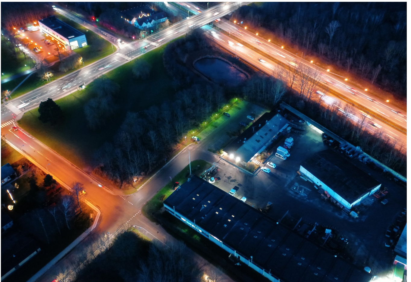
Dronefoto af parkeringen ved Materielgården ved Park Allé/Gammelkirkevej - eftermiddag
