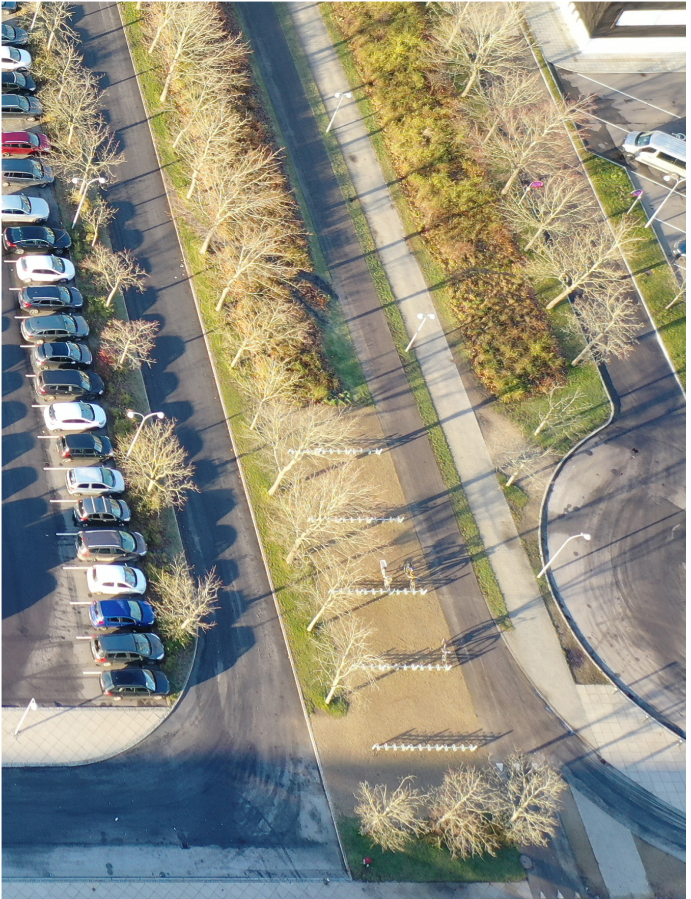
Dronefoto af cykelparkeringen ved Idrættens Hus - morgen
