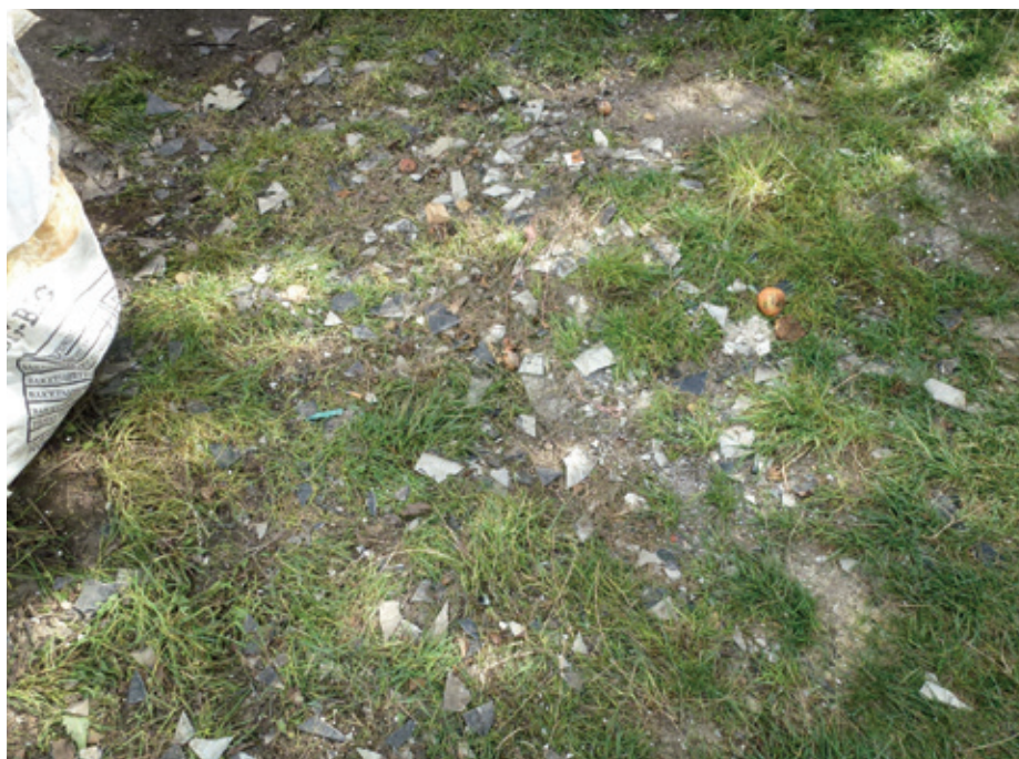
Efter selve tagpladerne er kørt væk ligger små stykker af asbest tilbage i jordoverfladen.
