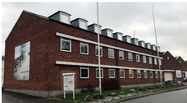
Administrationsbygningen ud mod Kirkebjerg Parkvej
