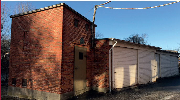
Transformerstation og garageanlæg
