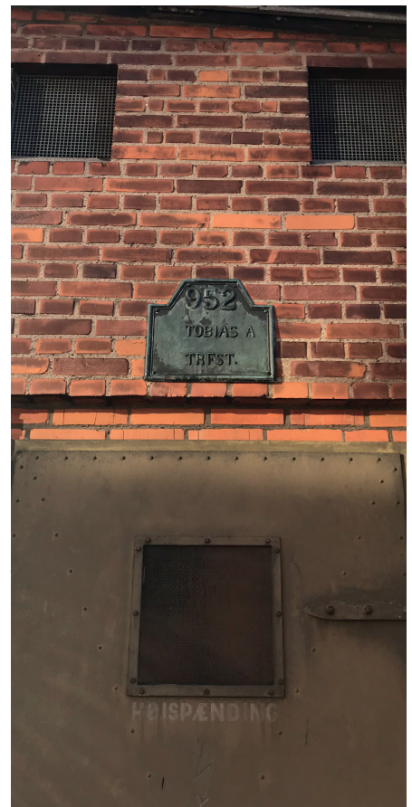
Transformerstation, Tobias Jensen, Kirkebjerg Parkvej 4
