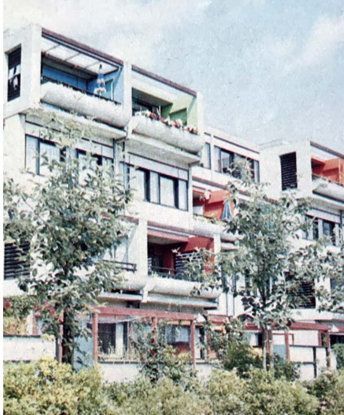
Terrassehusene og deres facadeforskydning inden inddækningen af altanerne. Svend Høgsbros vision om at kunne kombinere standardisering og variation, samt at betonen skulle fungere som baggrund for det grønne, ses tydeligt.
