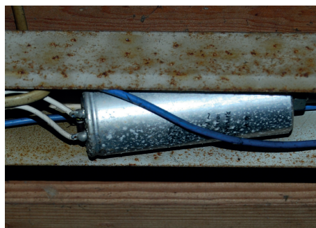
Ældre kondensatorer indeholder ofte PCB.
