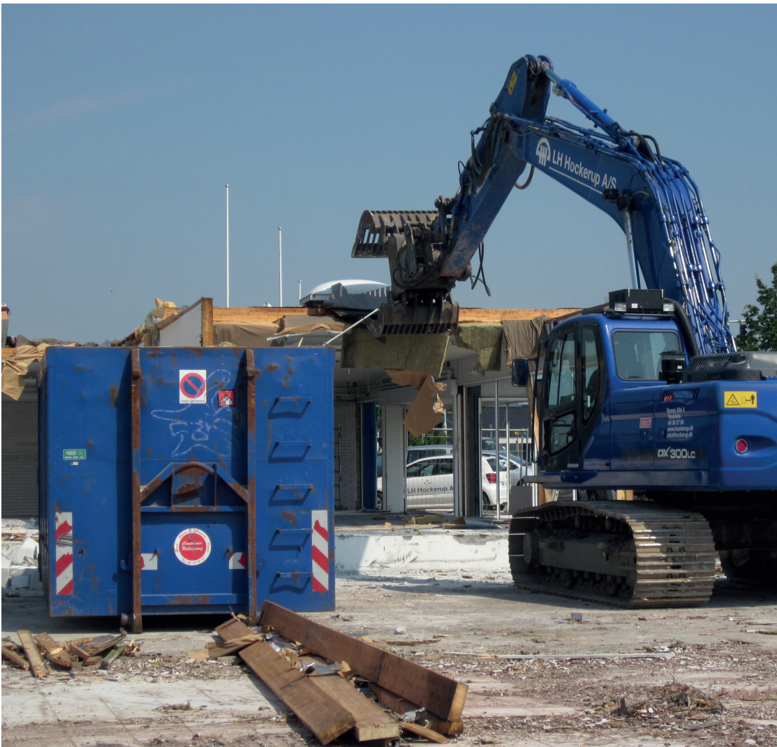
Nedrivning hvor affaldet sorteres umiddelbart.
