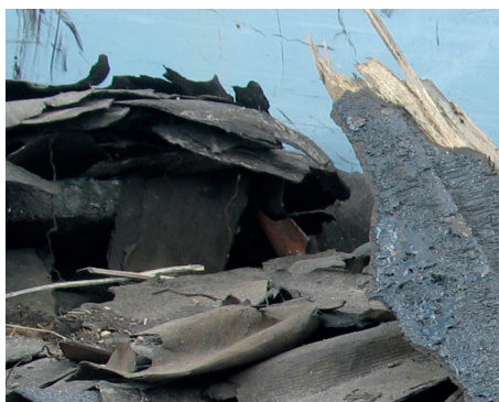
Ældre tagpap fra nedrivning. Ældre tagpap kan indeholde tjærestoffer. Tagpap deponeres eller genanvendes.
