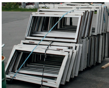
Vinduesrammer forurenet med PCB fra monterede PCB-holdige termoruder. Skal som udgangspunkt bortskaffes som farligt affald.
