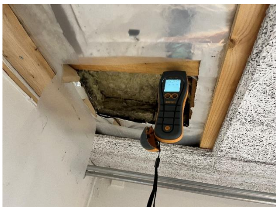
Billede 7, viser 2 lag dampspærre.
