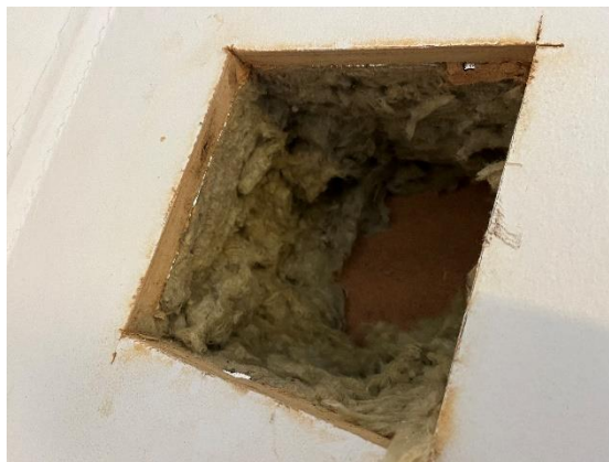
Billede 8, viser ydervægskonstruktion.
