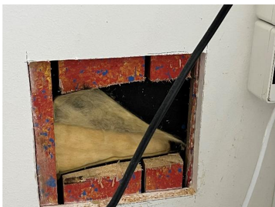
Billede 1, viser ydervæg ved destruktivt indgreb.
