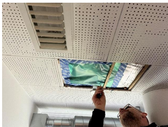
Billede 41, viser damppærre reparationer i loft over pin-up plader.
