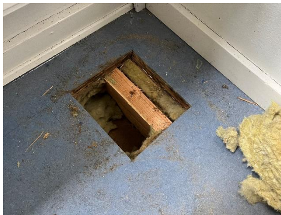
Billede 14, viser gulvkonstruktion.
